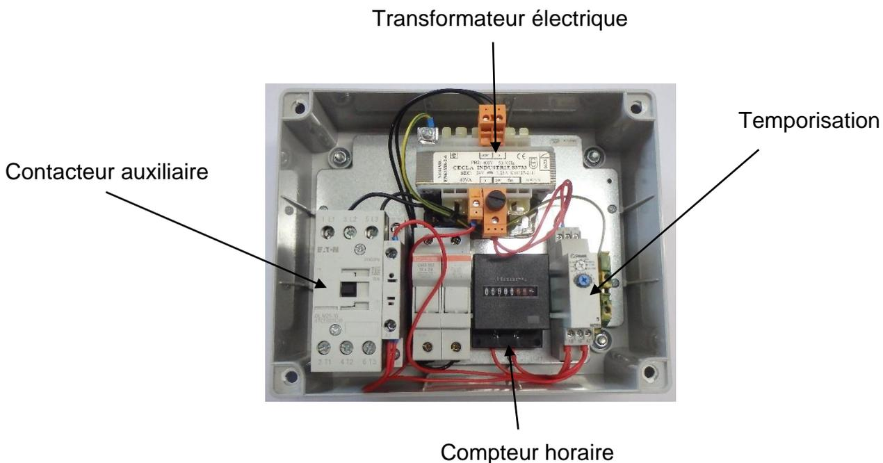
Coffret électrique basse tension, conforme à la réglementation en vigueur
