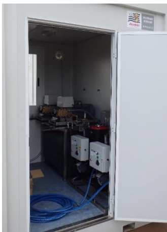
Nettoyeurs HP adaptés dans une construction modulaire
