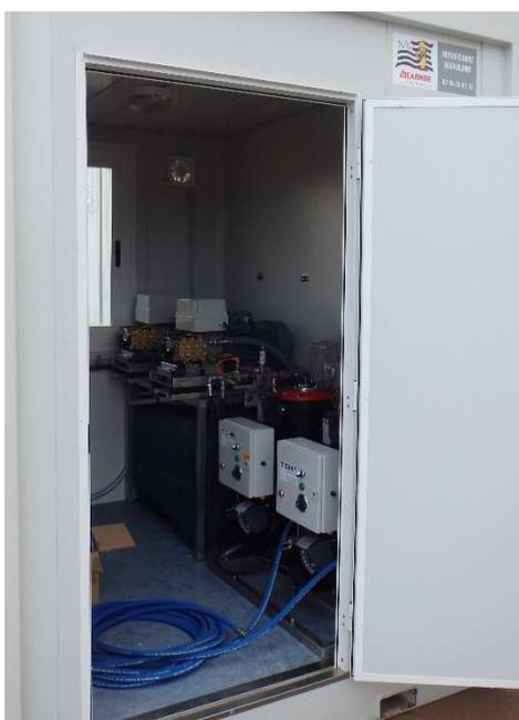
*Nettoyeurs HP adaptés dans une construction modulaire*
