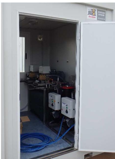
*Nettoyeurs HP adaptés dans une construction modulaire*
